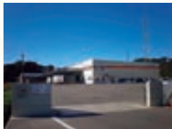
多久ロジネットセンター
