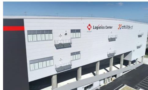
東大阪ロジスティクスセンター (大阪府東大阪市)
