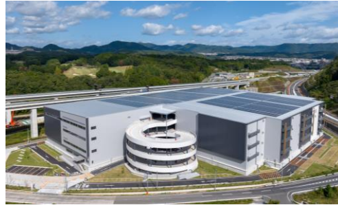
川西ロジスティクスセンター (兵庫県川西市)
