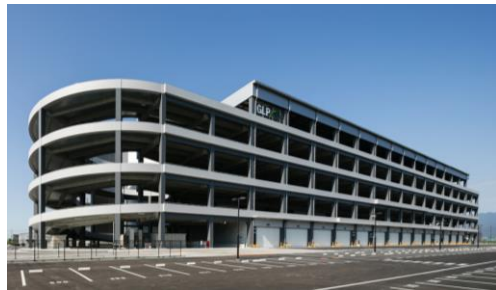
鳴尾浜ロジスティクスセンター (兵庫県西宮市)
