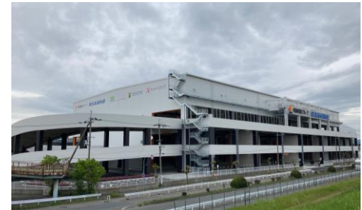
北大阪ロジスティクスセンター (大阪府茨木市)
